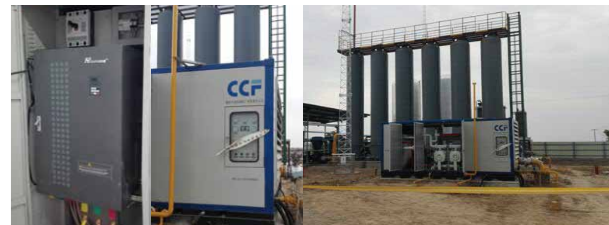
280KW变频器在压缩机上的应用
