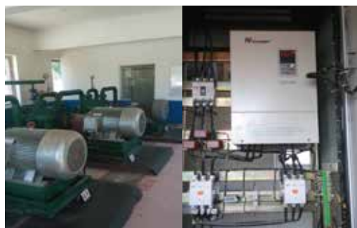
易驱ED3100系列变频器在油田开采注水井上的应用
